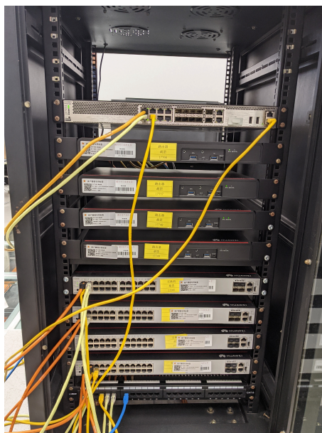
Figure 4: 机柜正面接线图
